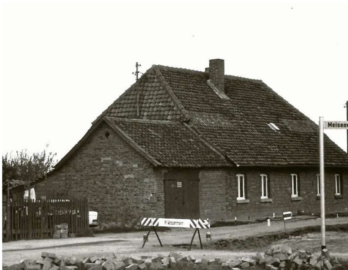
Das alte Spritzenhaus der Freiwilligen Feuerwehr Vechelade.
