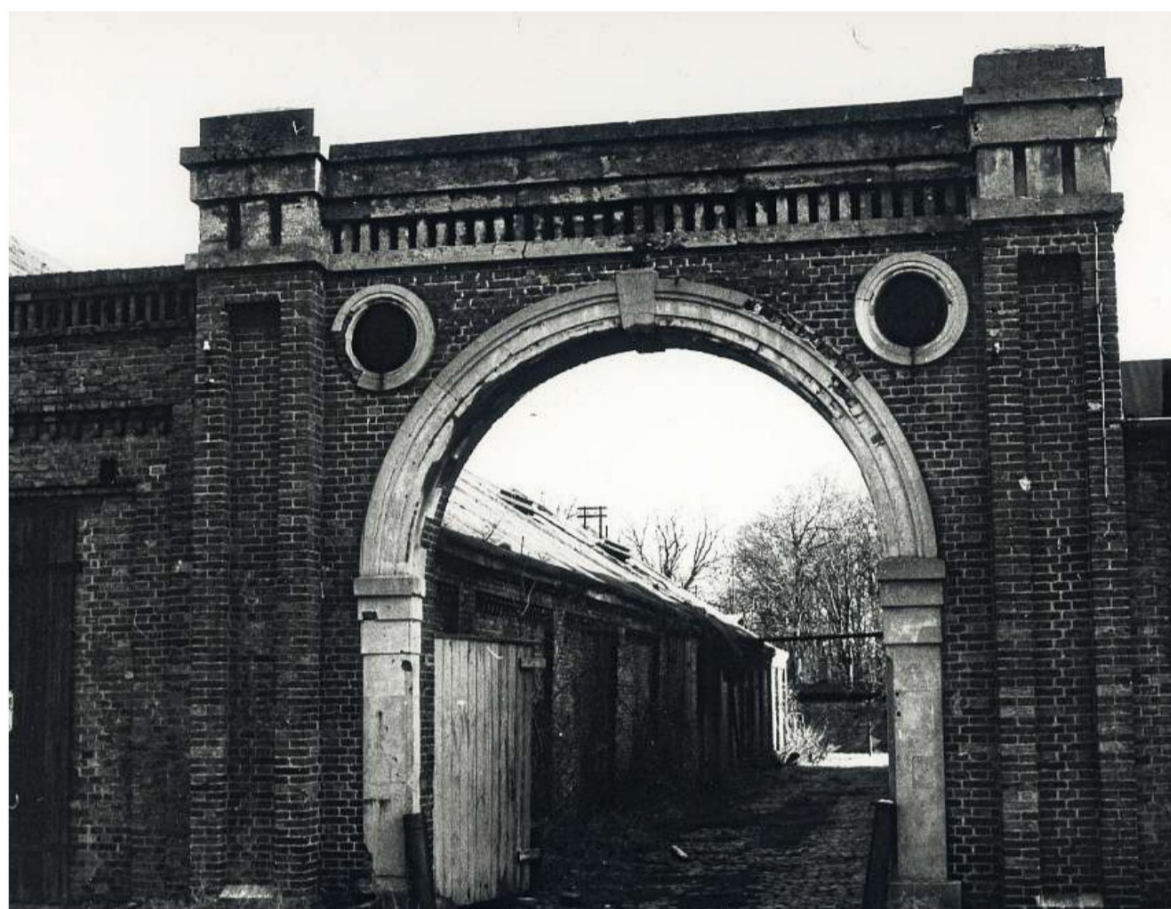
Das Fabriktor zur Jutespinnerei in Vechelade an der Spinnerstraße in 1976: Heute steht nur noch das Tor. Die Werksfeuerwehr der Spinnerei ist als Vorläufer der Freiwilligen Feuerwehr Vechelade/Vechelade zu sehen. FOTO: ARCHIV
